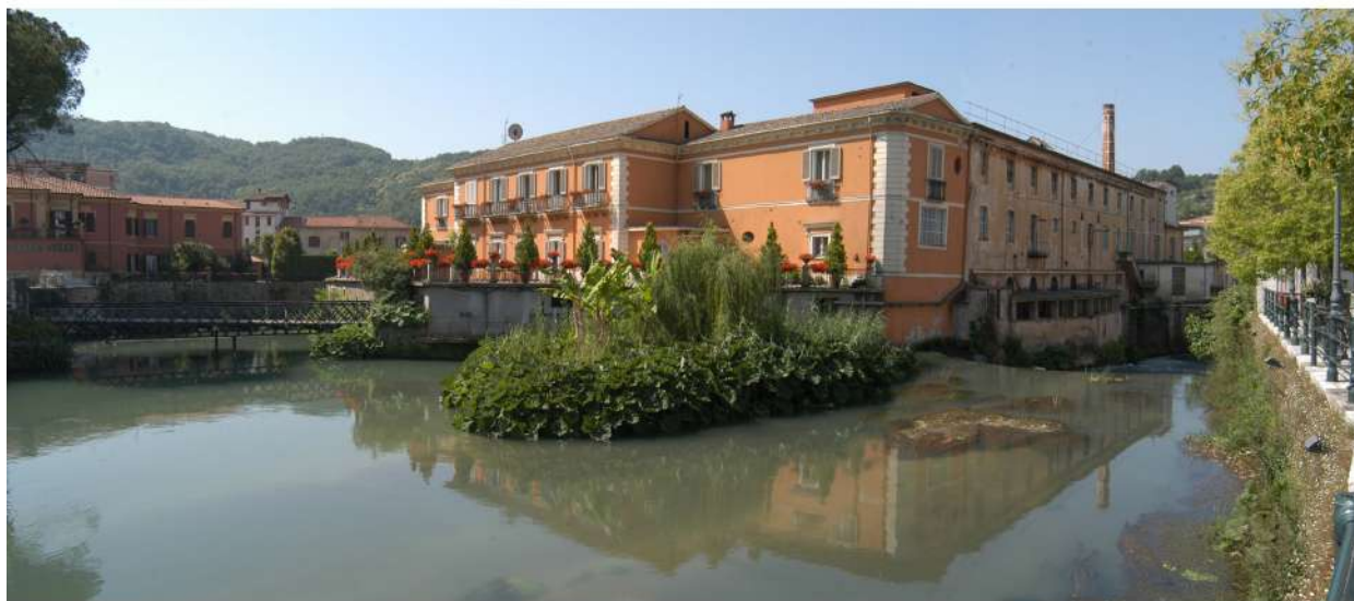
Fig. 7: Isola del Liri. Cartiera A. Mancini (già Courier). Vista verso il fronte principale e parte dell'ala destra. (Foto W. Pagnanelli, Isola del Liri).
