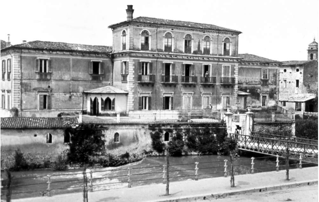
Fig. 8: Isola del Liri. Edificio scolastico (ex Cartiera Courier). Da notare la sopraelevazione dell'ultimo piano, oggi non più esistente in seguito al crollo determinato dal terremoto del 13-1-1915. (Sul retro dell'originale è riportata a penna la data 23-7-1912). (Prop. orig. U. Rea, Isola del Liri).
