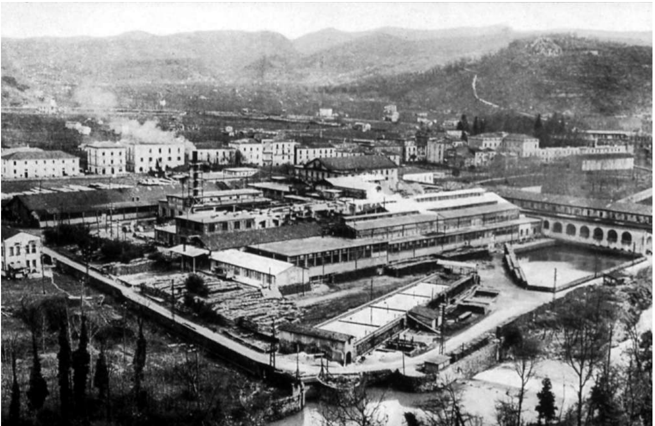
Fig. 3: Isola del Liri. Società delle Cartiere Meridionali. Veduta generale dello Stabilimento "Liri". (Da Isola del Liri , monografia redatta e ordinata dall'ing. O. EMERY, Isola del Liri anno XIII E.F. [1935], p. 95).
