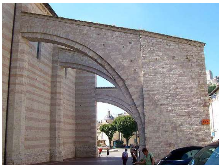
Fig. 31: Assisi. Basilica di Santa Chiara. Gli archi rampanti. (Foto Geobia).
