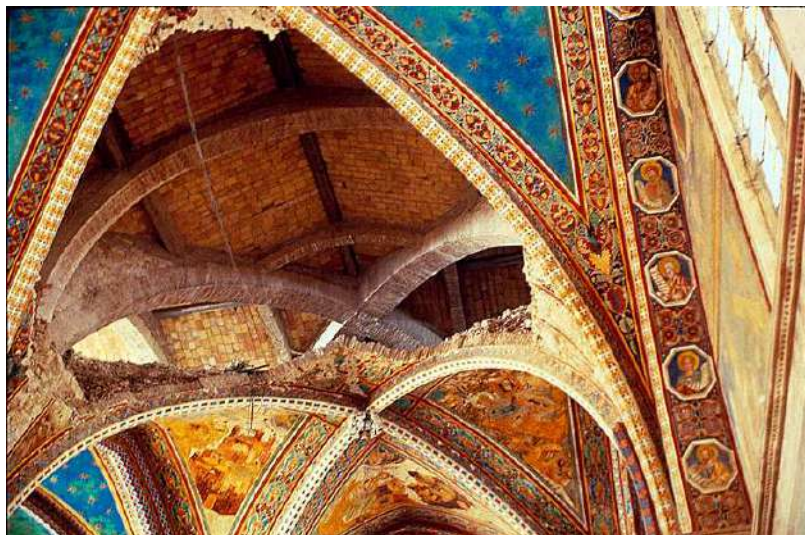
Fig. 4: Assisi. Basilica di San Francesco. Le volte della Chiesa superiore dopo i crolli in seguito al terremoto del 1997.
