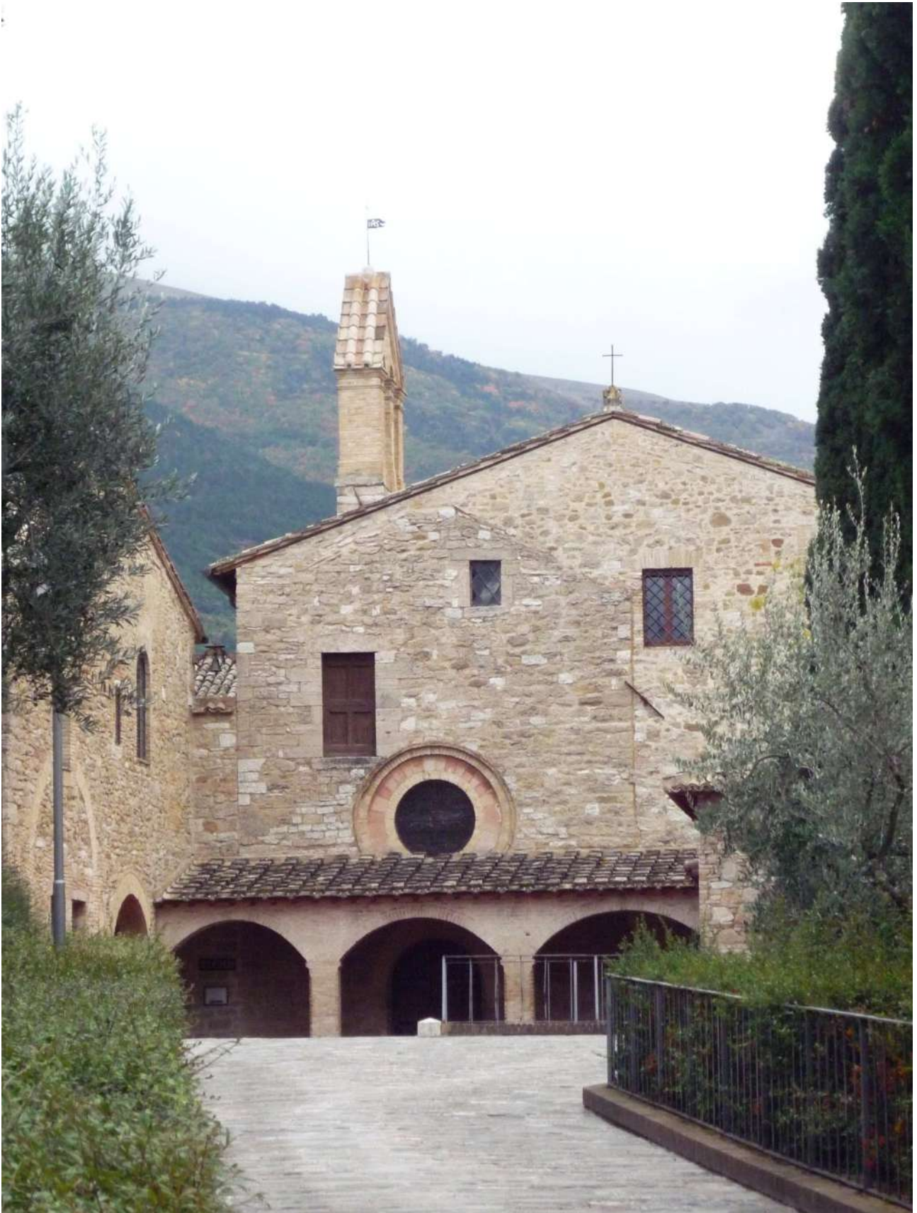
Fig. 51: Assisi. Chiesa di San Damiano. Esterno. (Foto Fczarnowski).
