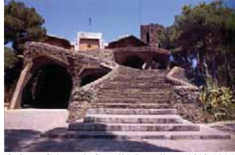
8. Santa Coloma de Cervelló, Barcellona (1898-1915) Cripta della chiesa della Colònia Güell. Veduta d'insieme.
