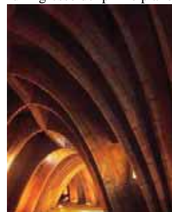
21. Barcellona. Casa Milà. Particolare del desván con gli archi parabolici che reggono la copertura.
